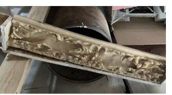
THE DECTORATIVE PLASTER TRIMWORK WAS HAND-RESTORED LOCALLY, | AS WELL AS THE PAINTED FLOORS AND MISSING STAINED GLASS.
